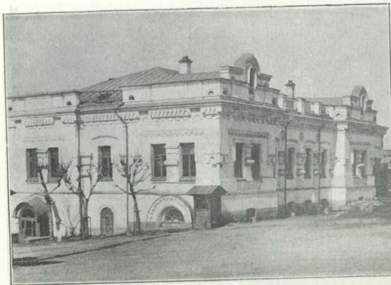
FIG. 8. La maison Ipatief vue, du coin de la perspective Voznessensky et de la ruelle Voznessensky.
